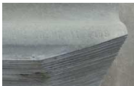
Figuur 2: golfplaten, asbestvrij
