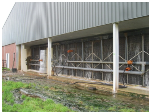
Figuur 17: Homogeniteitsmetingen met een Lasergas-monitor op een biologische luchtwasser
