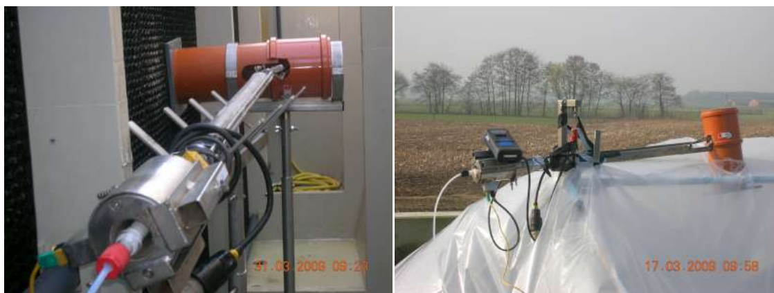
Figuur 9: Natchemische monsternemingen van NH 3 in de ventilatielucht na de luchtwasser
