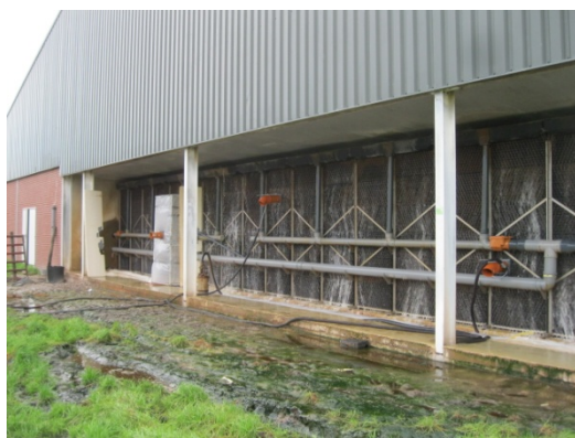
Figuur 17: Homogeniteitsmetingen met een Lasergas-monitor op een biologische luchtwasser
