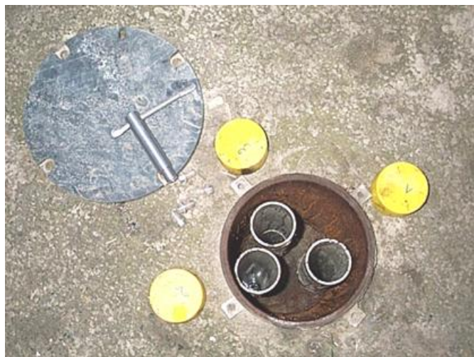
Figuur 4: afgewerkte peilput van het freatisch grondwatermeetnet met drie peilbuizen (bron: DOV).
