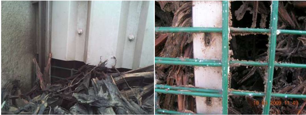
Figuur 1: Gaten in de luchtwasser
