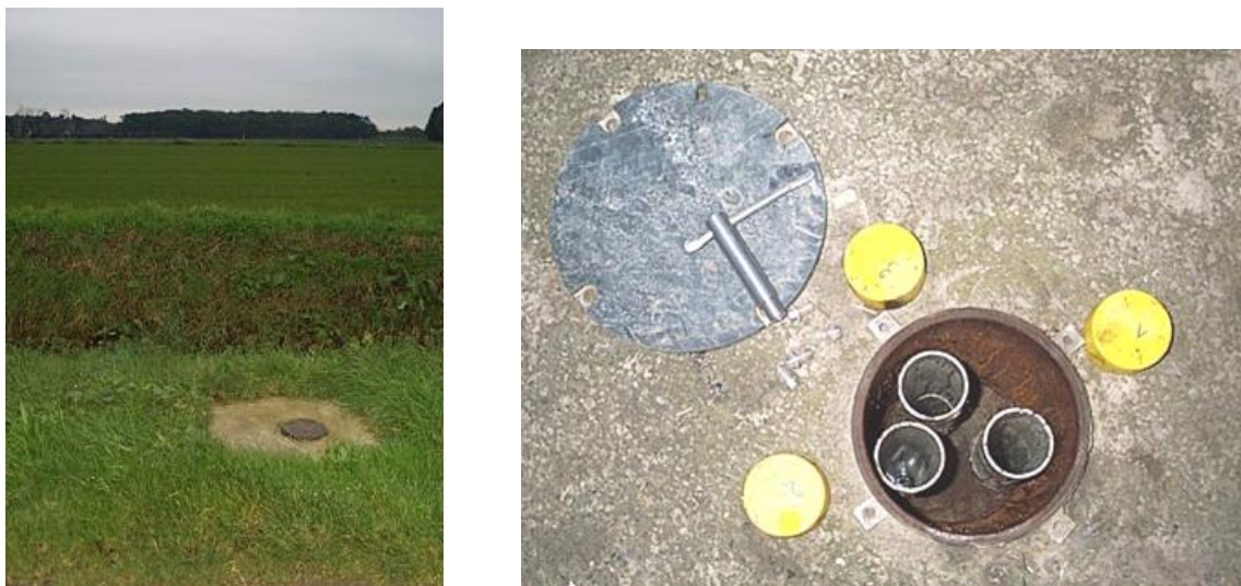
Figuur 4: afgewerkte peilput van het freatisch grondwatermeetnet met drie peilbuizen (bron: DOV).
