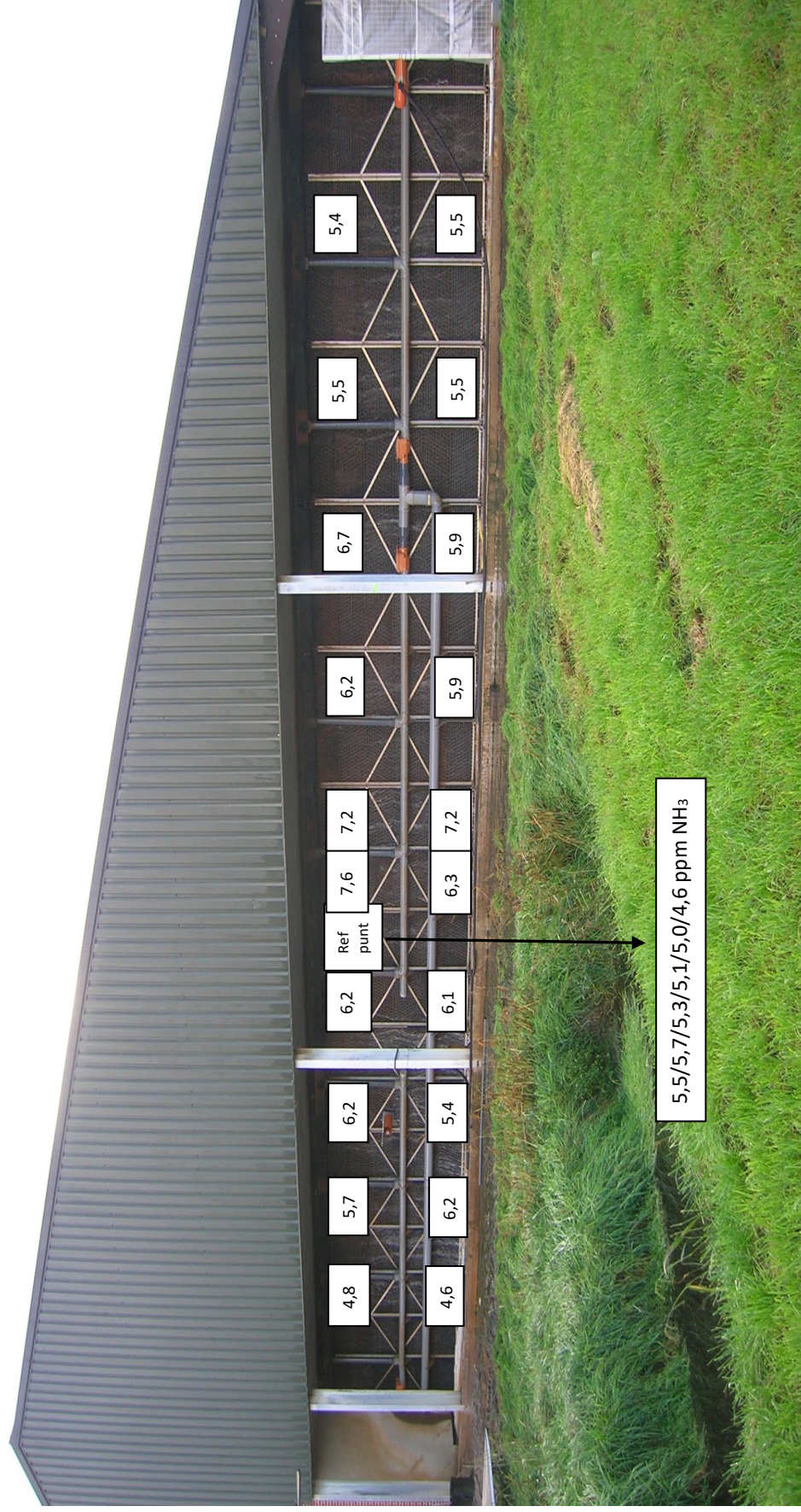
Figuur 22: Homogeniteitsmetingen bij een biologische luchtwasser te Hoogstraten
