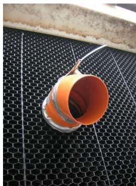
Figuur 5: Toepassing van een opzetstuk om windinslag te vermijden
