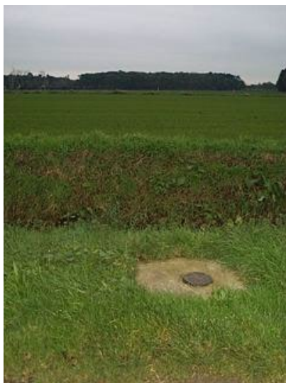
Figuur 4: afgewerkte peilput van het freatisch grondwatermeetnet met drie peilbuizen (bron: DOV).
