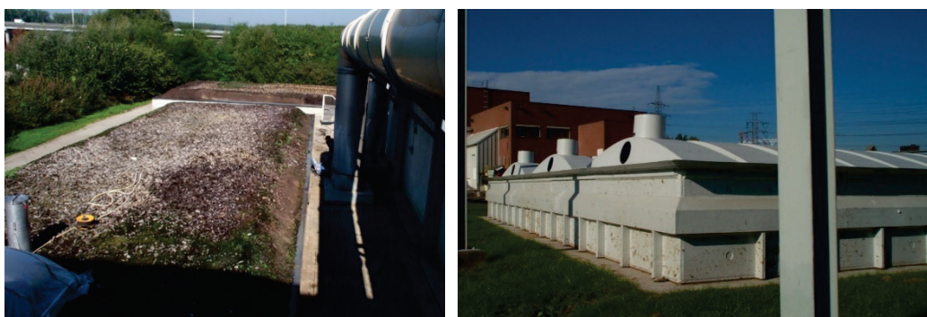
Figuur 4: Open biofilter (links) en gesloten biofilter (rechts)
