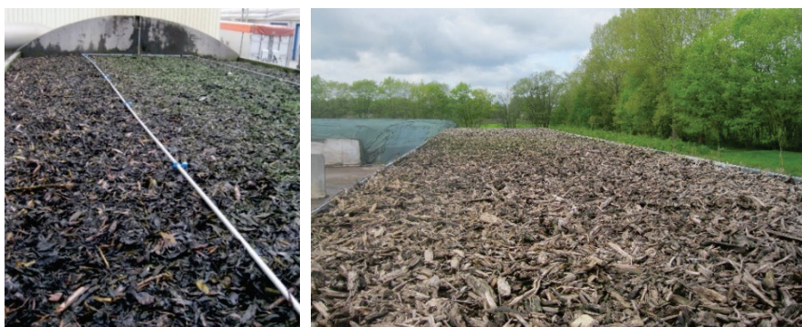
Figuur 2: Voorbeelden horizontale biofilters
