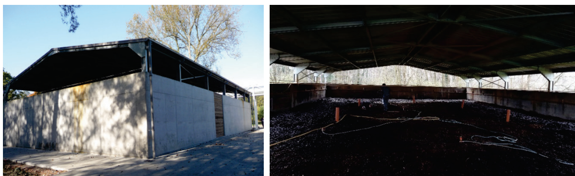
Figuur 11 : Horizontale biofilter voor verwijdering VOS
