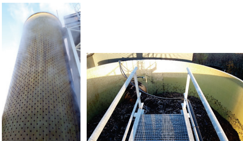
Figuur 3: Voorbeeld verticale biofilter
