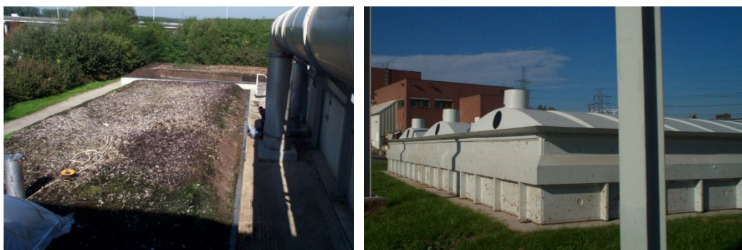
Figuur 4: Open biofilter (links) en gesloten biofilter (rechts)
