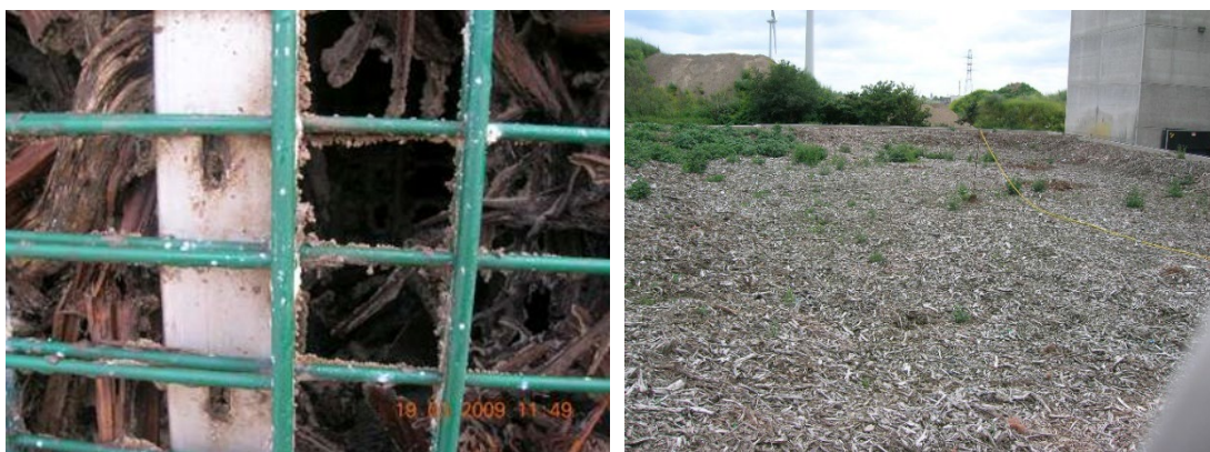
Figuur 5: Aanwezigheid van gaten in het biofiltermateriaal (links) en optreden van begroeiing op de biofilter (rechts)
