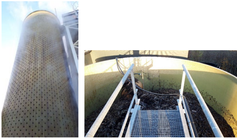
Figuur 3: Voorbeeld verticale biofilter
