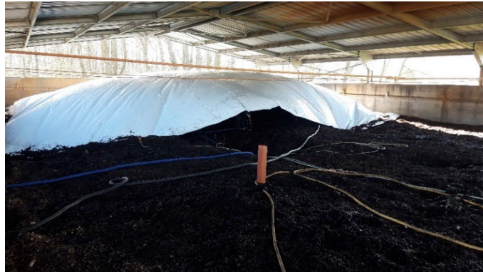
Figuur 24: Afdekking van een gedeelte van de biofilter (zone 3-4) met een zeil
