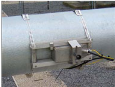
Figuur 27: opklembare ultrasone debietmeter
