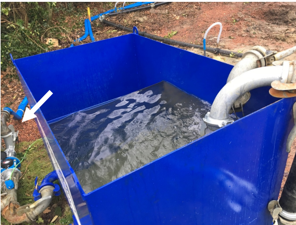
Figuur 15: bemaling waarbij de ontluchting via een open verzamel-/ontluchttingsbak voor de watermeter werd geïnstalleerd. Let ook op de zwanehals na de watermeter (witte pijl). Er zijn te veel bochten en een aftakking te kortbij de aanvoer van de watermeter.
