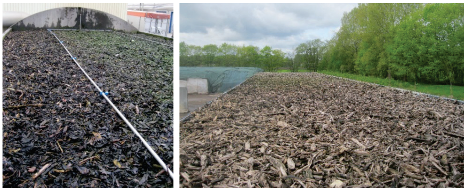
Figuur 2: Voorbeelden horizontale biofilters
