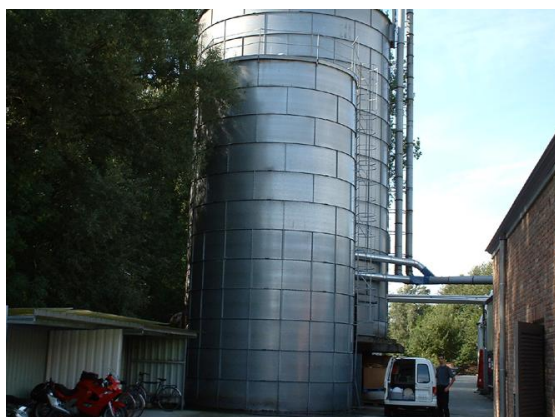
Foto 1a/b: Opslagsilo met houtstof bij meubelverwerkend bedrijf
